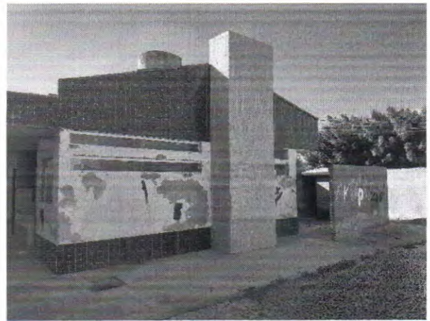
Fachada externa do Bloco de Serviço
