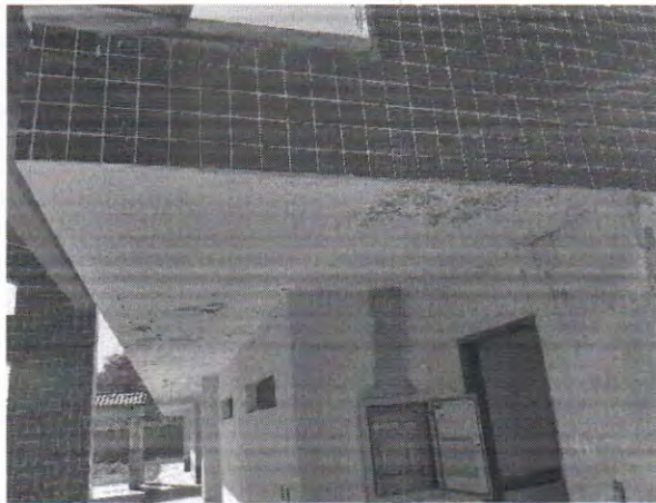
Quadro Elétrico da Creche I
